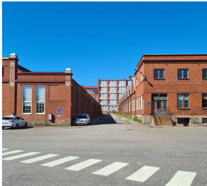
Figur 5. Kv. Gösen. Arvid Palmgrens gata sedd från söder. (Platsbesök 2022-08-12)
